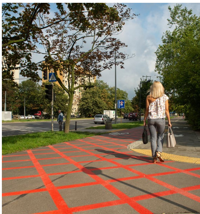
Zdjęcie 2 ul. Okopowa. Przykład oznakowania miejsca przecięcia ruchu pieszego i rowerowego.
