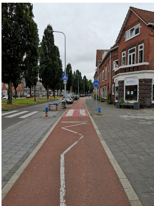
Zdjęcie 1 Holandia. Przykład oznakowania poziomego informującego o zbliżeniu się do przejścia dla pieszych.
